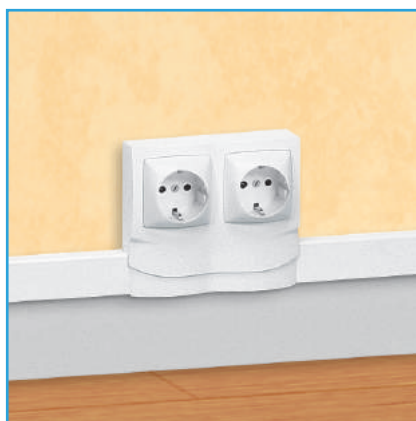
Oteo szerelvények csatornához rögzítése
